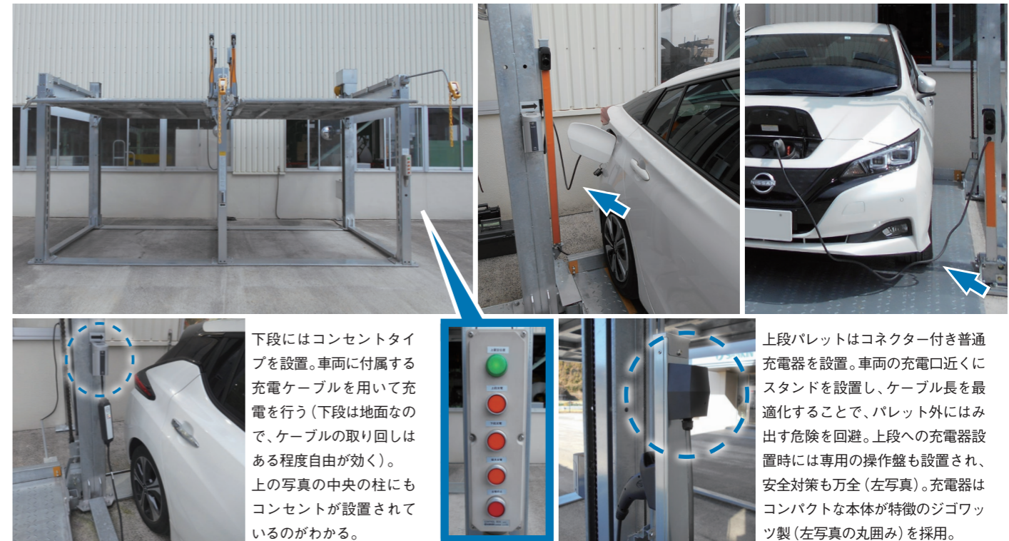
■ 下段にはコンセントタイプ、上段には普通充電器を設置
